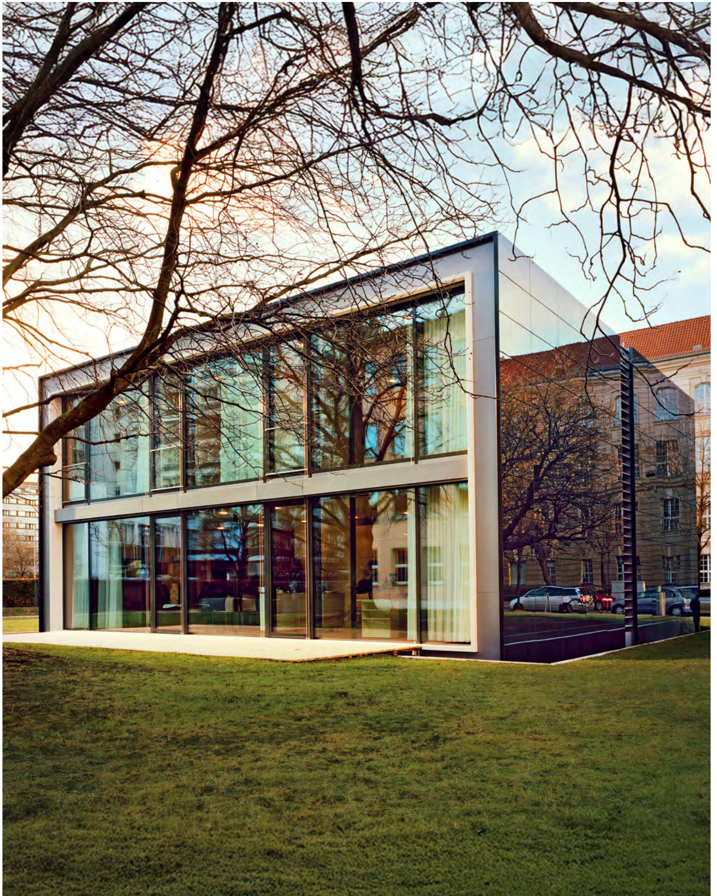
西南外立面覆蓋有光伏電池。東北外立面覆有通風防雨層，採用黑色玻璃框，看上去結構一致
